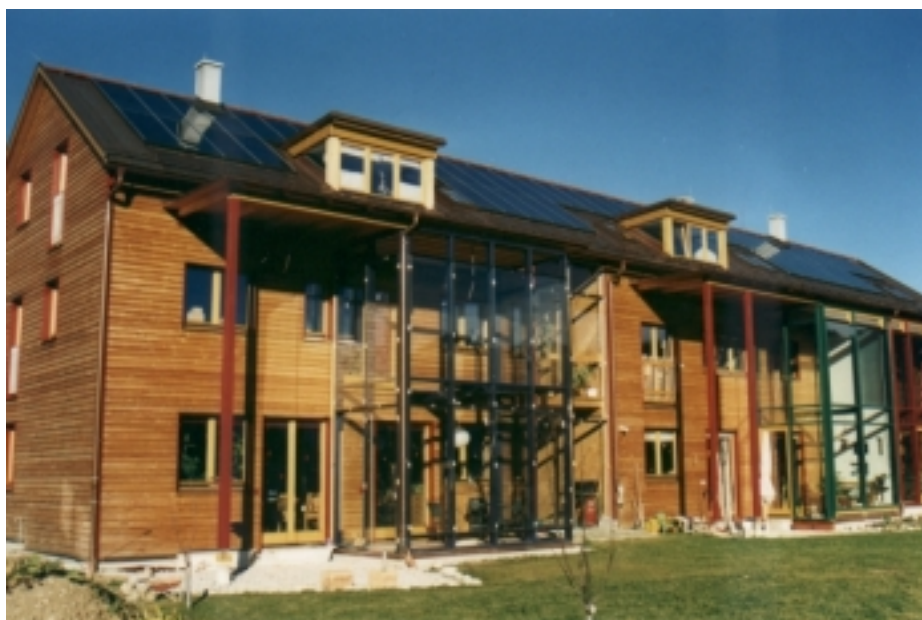
Abbildung 4: Wohnprojekt Kuchl-Jadorf, Thermische Solaranlage für 10 Wohneinheiten
