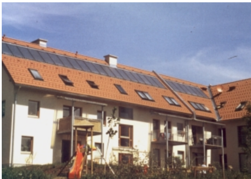
Abbildung 40: Üblicherweise erfolgt die Warmwasserverteilung bei solaren Warmwasserbereitungssystemen über ein zentrales Verteil- und Zirkulationsnetz
