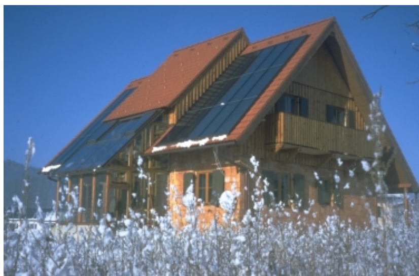
Abbildung 2: Einfamilienhaus mit solarer Warmwasserbereitung und Heizungsunterstützung
