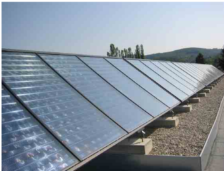
Thermische Solarkollektoren auf einem Wohnhaus 4
