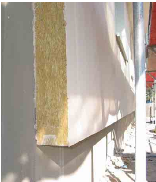
Während der thermischen Sanierung eines Wohnhauses (Quelle: Grazer Energieagentur)
