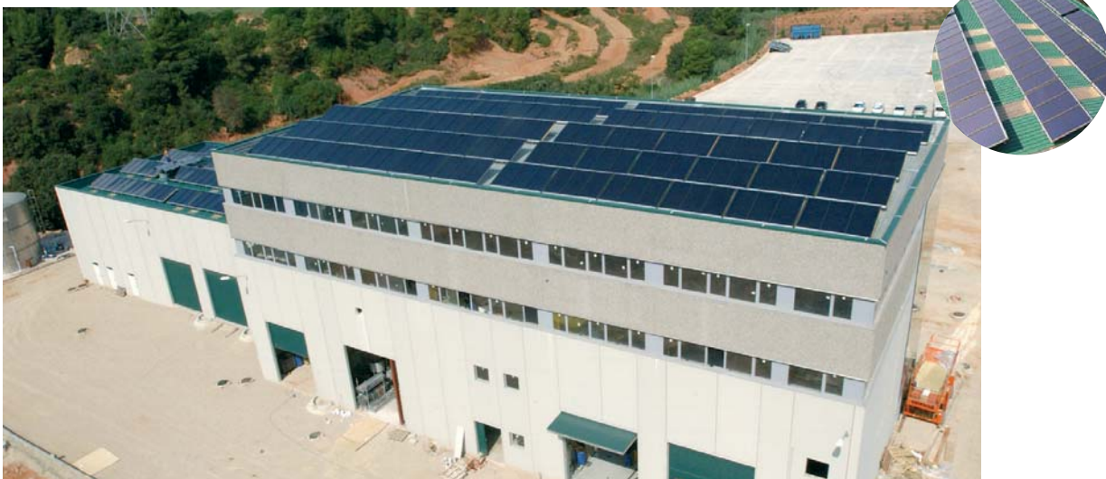
Abbildung 4: Hallenansicht und Detailansicht Kollektoren – Contank, Spanien
