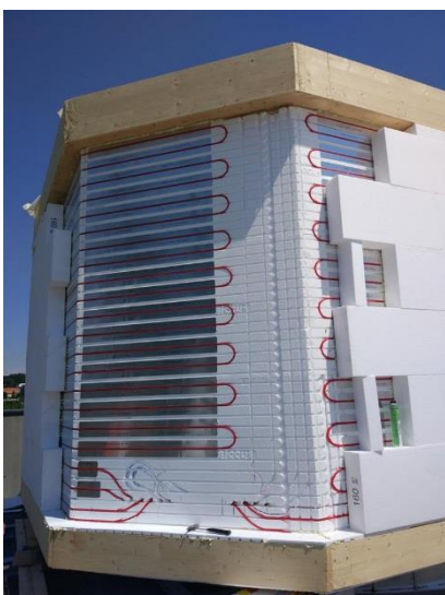
Abbildung 3 zeigt eine Außenansicht der Test- und Prüfboxen für Fassaden und Fassadenelemente in der Bauphase. Deutlich ist die äußere hydraulische Kompensationsebene zwischen zwei Dämmschichten zu erkennen (Bildquelle AEE INTEC).
