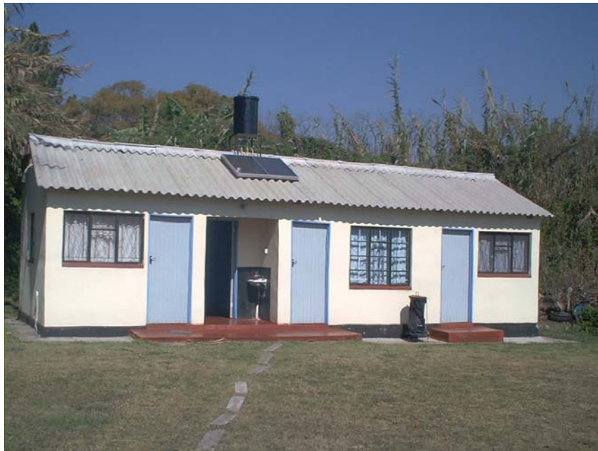
Abbildung 2: Solaranlage mit einem 100 Liter Speicher. Die vertikalen, drucklosen Speicher sind einfach zu fertigen und haben ein sehr gutes Schichtungsverhalten.
