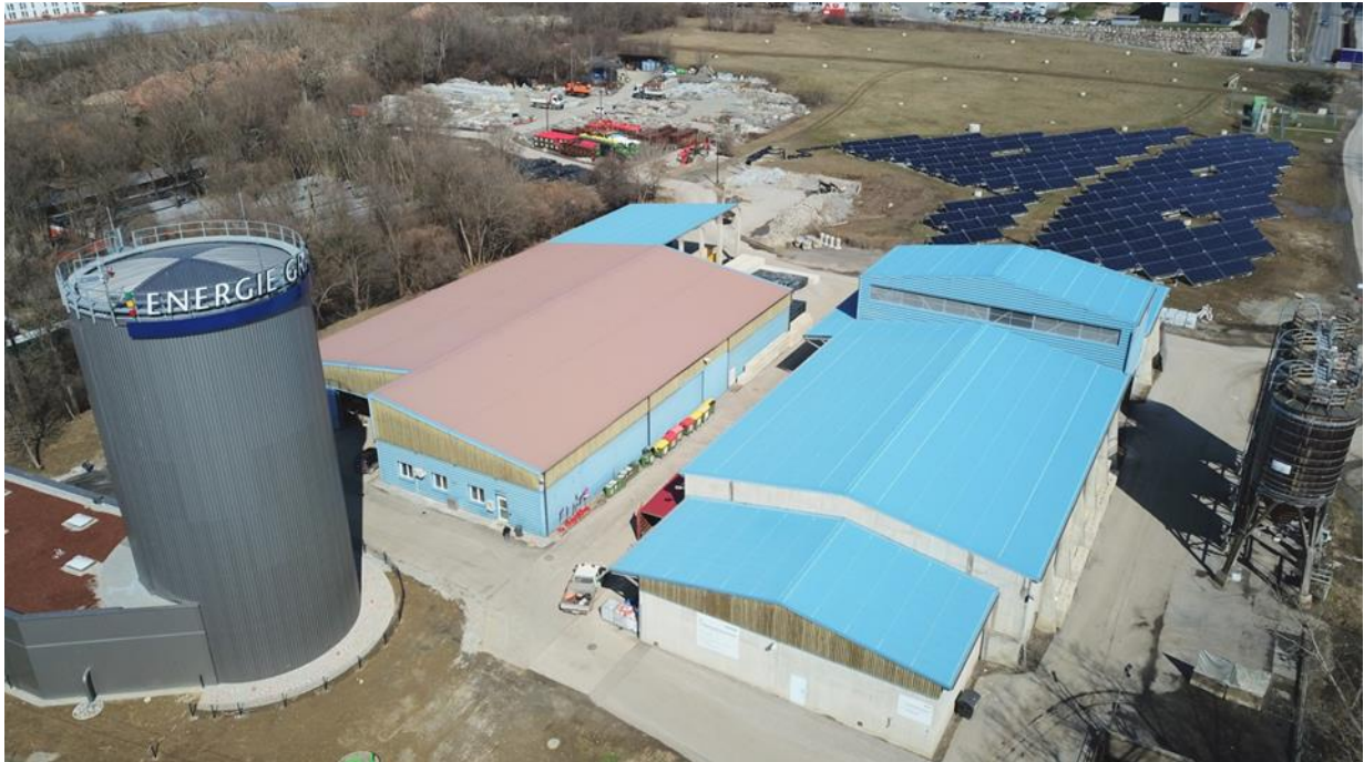
Abbildung: HELIOS-Projekt in Graz (Quelle: AEE INTEC)
