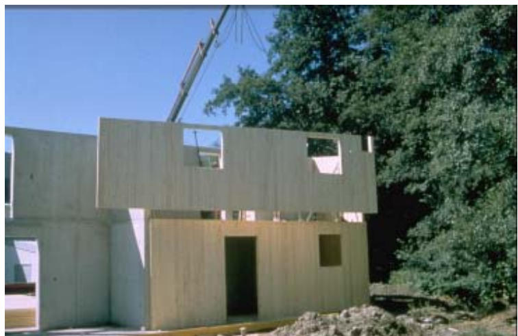
Abb. 4: Versetzen der Holz-Fertigteilmwände
