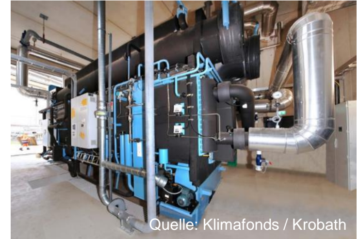
Abwärmenutzung Hallein - Absorptionswärmepumpe
