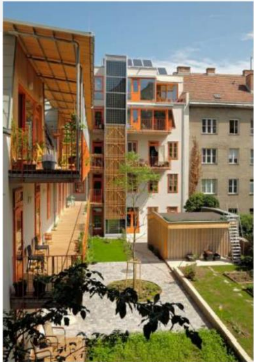
Innenhof "Smart Block Geblergasse" nach Fertigstellung der Erdsondenbohrungen © Lisi Zeininger, Zeininger Architekten. www.zeininger.at
