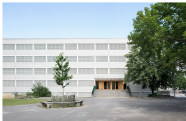
Waldorfschule Prenzlauer Berg, Berlin MONO-Architekten; Niehues & Winkler Ingenieure; Pampelbau Bildquelle: https://holzbauatlas.berlin/fassadensanierung-sk-plattenbau-mono-architekten/ Fotograf: Gregor Schmidt
