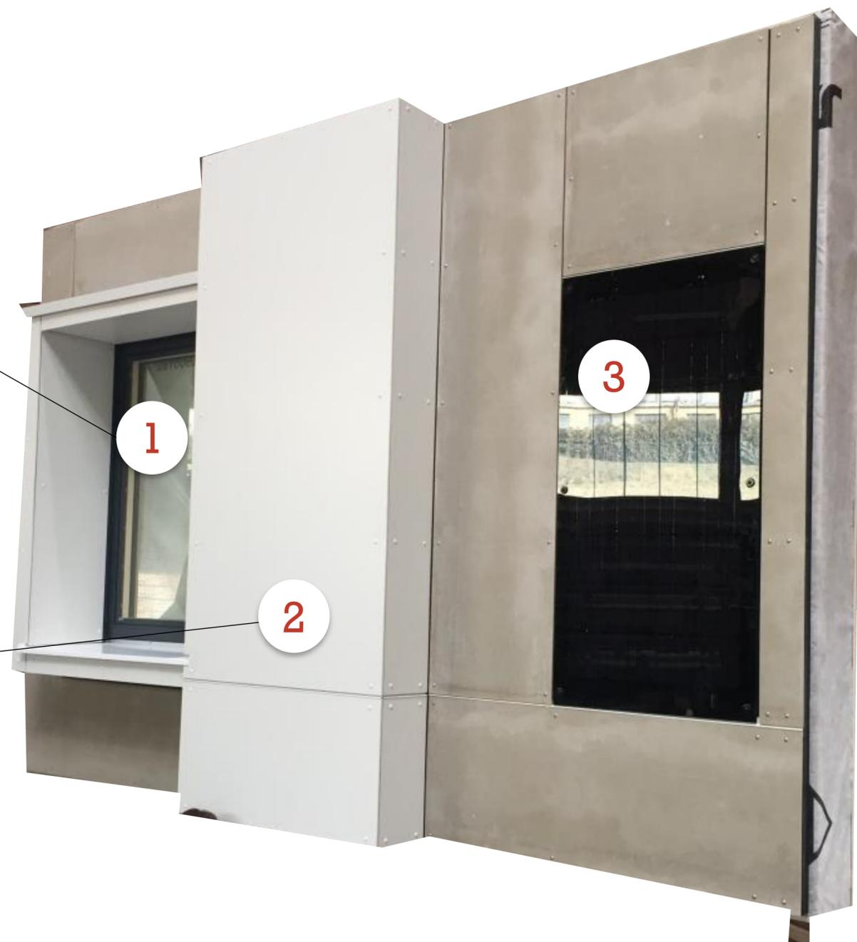
① Fenster mit Integrierter Zuluftöffnung und Luftvorwärmung über den Zwischenraum
