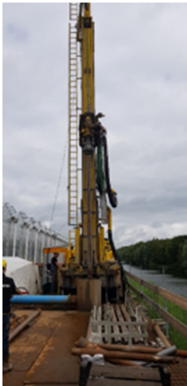
1. Bohren des Brunnen
