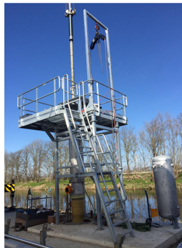
3. Installieren der untergetauchten Pumpen
