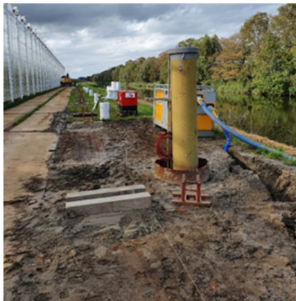
2. Installieren von Brunnenröhre
