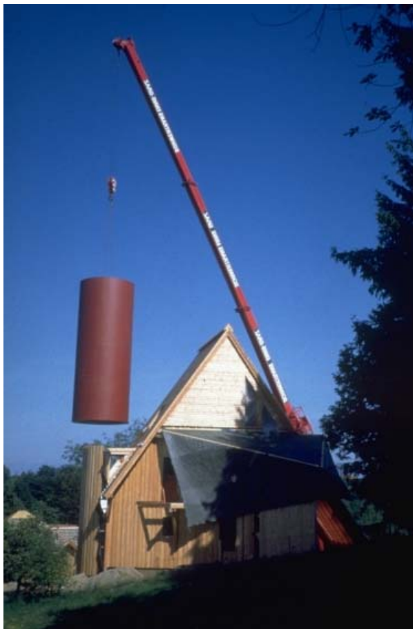
Abb.2: Einbringung des 75 \text{ m}^3 fassenden Saisonspeichers
