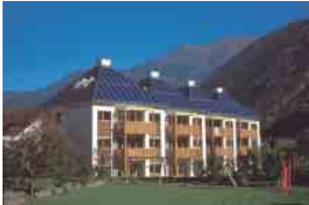
Kollektoren als Dach
