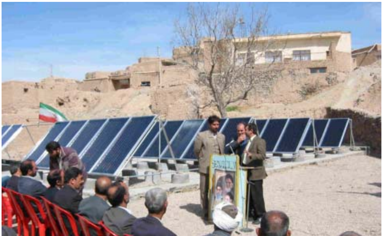
Abb. 23: Inbetriebnahme einer Solaranlage im Iran, die von der österreichischen Firma GREENoneTEC 2004 errichtet wurde.
