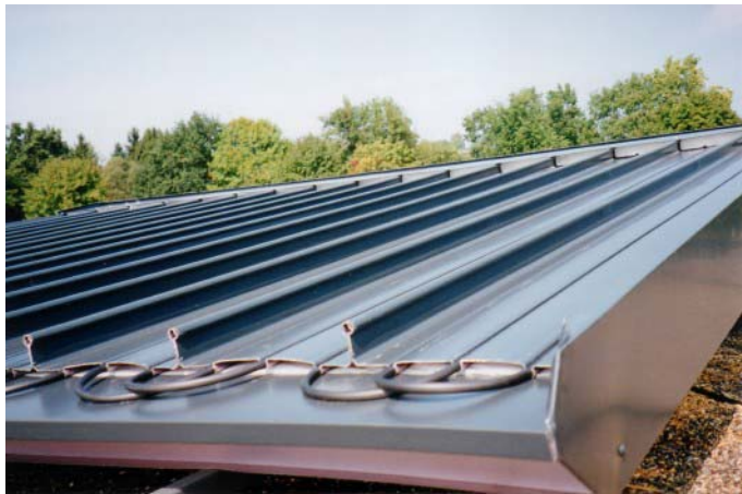
Abbildung 7: In weiterer Folge wurde der EMA Schlauch montiert. Da dafür noch keine Maschine zur Verfügung stand, erfolgte dies manuell mit einem Hilfswerkzeug. Der Schlauch wurde mit Spülmittel geschmiert und mit einer Rolle in das Klemmprofil gedrückt.
