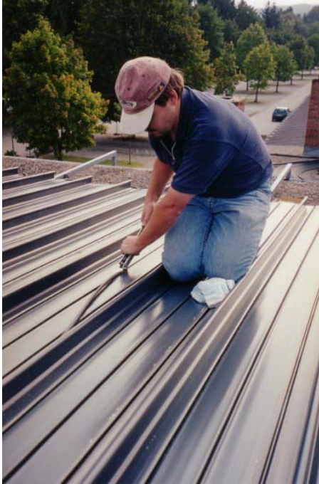
Abbildung 7: In weiterer Folge wurde der EMA Schlauch montiert. Da dafür noch keine Maschine zur Verfügung stand, erfolgte dies manuell mit einem Hilfswerkzeug. Der Schlauch wurde mit Spülmittel geschmiert und mit einer Rolle in das Klemmprofil gedrückt.
