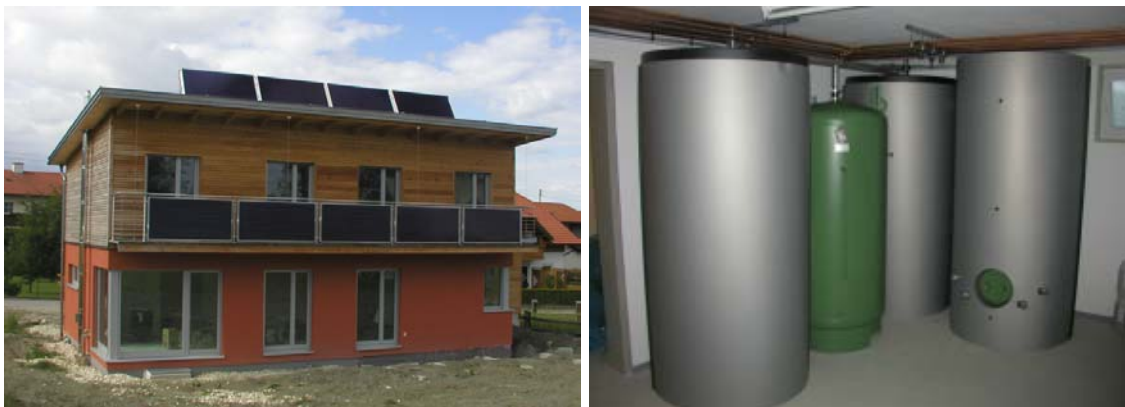
Abb. 1: Pilotanlage mit Dach- und Balkonkollektoren sowie Sorptions- und Pufferspeicher Für den Betrieb der Pilotanlage wurde außerdem eine frei programmierbare Regelung entwickelt, mit der der Normalbetrieb im Einfamilienhaus sowie spezielle
