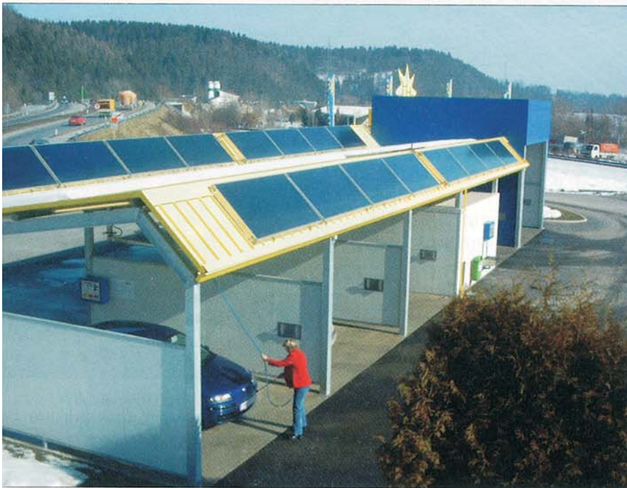
Österreichs erste solare Autowaschstraße.
