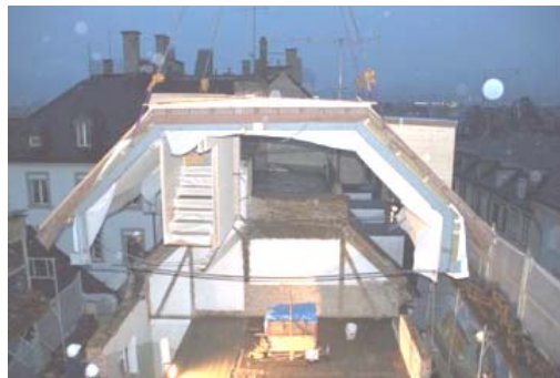
Renovation project Magnusstrasse Zurich, arch. K. Viridén
