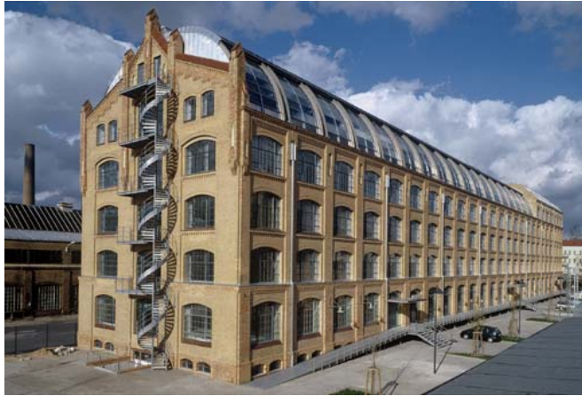
Energetische Transformation einer Stockwerksfabrik - Das ehemalige Hauptlager der AEG in Berlin-Oberschöneweide ÖKOSAN '07 FRANK AUGUSTIN BERLIN
