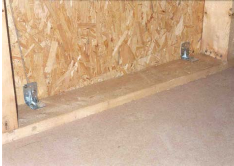
Abbildung 1.8: Befestigung der Kollektorrückwand (OSB-Platte) an den Holzriegeln mit Stahlwinkeln
