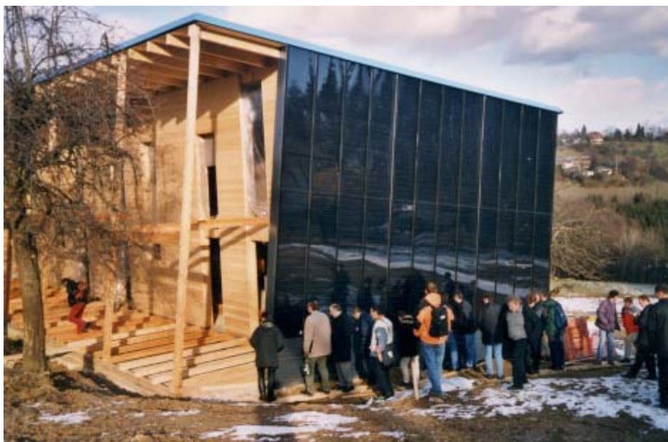
Abbildung 1.2: Testanlage: Zweifamilienhaus, 55 m 2 Bruttokollektorfläche (Absorber mit Solarlack), 3570 l Schichtspeicher, 500 l Brauchwasserspeicher, 12 kW Heizlast, 240 l/d Warmwasser mit 60°C.
