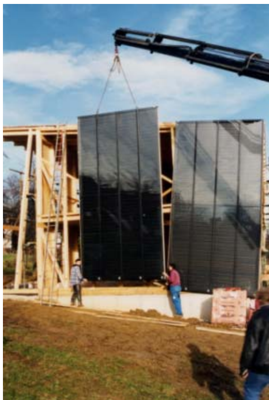
Abbildung 1.4: Montage der Kollektoren mit Hilfe eines Kranes. Das Kollektorfeld besteht aus drei Elementen zu je 18,3 m 2 .
