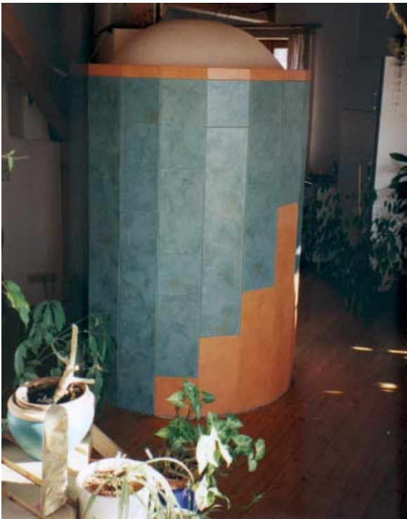
Abbildung 1: Kachelofen zur Ganzhausheizung mit eingebauten Wärmetauscher
