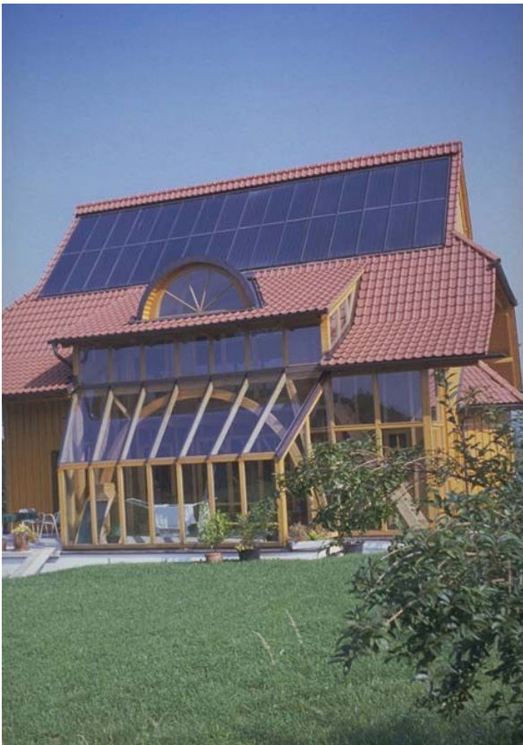
Abbildung 2: Niedrigenergiehaus mit Kachelofenganzhausheizung
