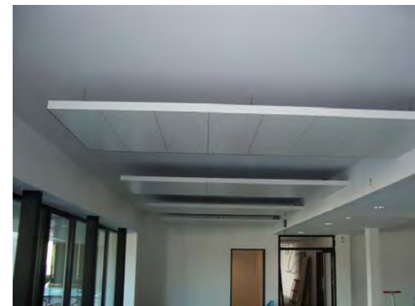
Kälte-Wärmeverteilung NEU
