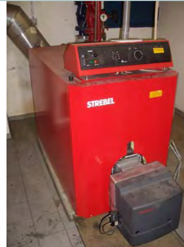
Ölkessel Bestand 250kW
