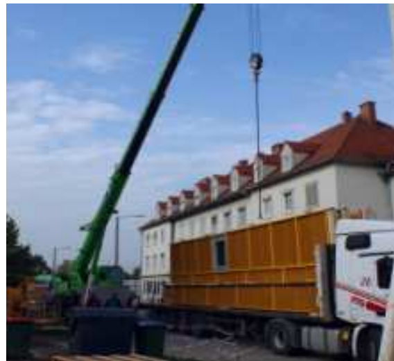
Bild 4-1, Bild 4-2: Anlieferung vorgefertigter Elemente BV Dieselweg, Graz-Liebenau (AEE INTEC 2009)
