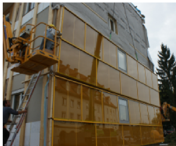
Bild 4-3, Bild 4-4: Montage vorgefertigter Elemente BV Dieselweg, Graz-Liebenau (AEE INTEC 2009)
