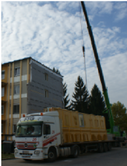
Bild 4-1, Bild 4-2: Anlieferung vorgefertigter Elemente BV Dieselweg, Graz-Liebenau (AEE INTEC 2009)
