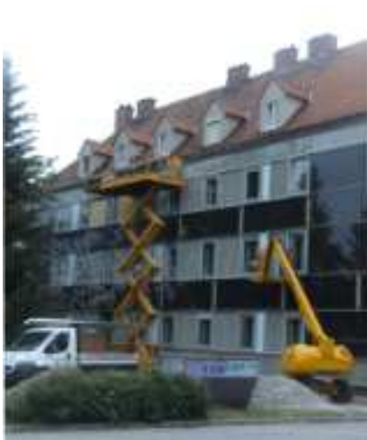
Bild 4-3, Bild 4-4: Montage vorgefertigter Elemente BV Dieselweg, Graz-Liebenau (AEE INTEC 2009)
