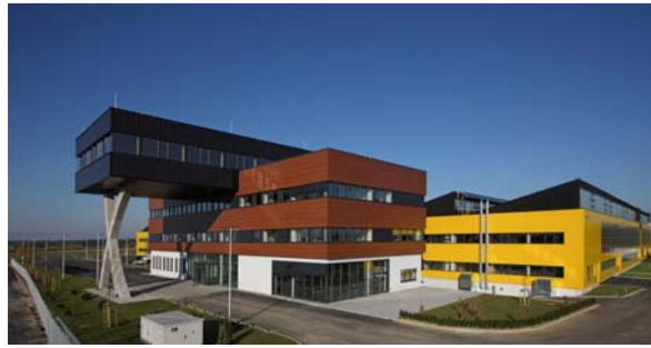
Firmengebäude Sunmaster (Quelle: Fa. Sunmaster)
