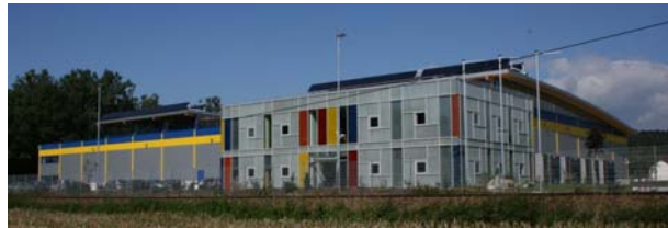
Firmengebäude Gasokol (Quelle: Fa. Gasokol)
