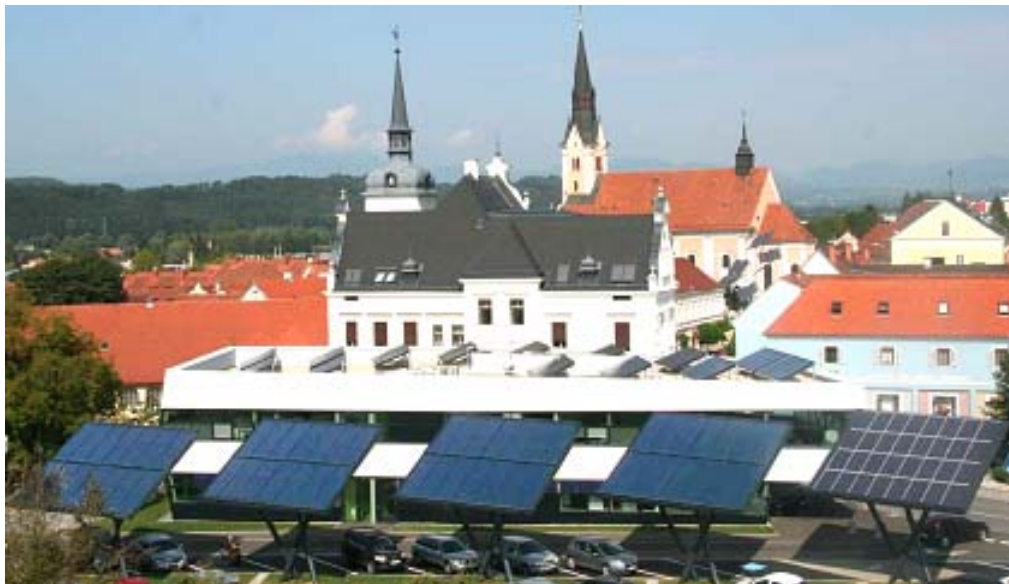
Abb. 1 – Im Vordergrund 4 Solarbäume und 1 PV-Baum, dahinter das Service Center mit Dachkollektoren und in dessen Hintergrund das Rathaus (Quelle: S.O.L.I.D. GmbH)
