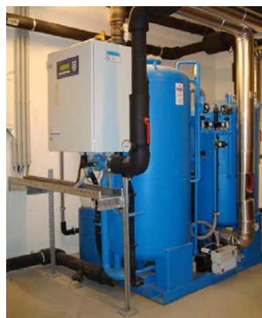
Abbildung 1 – links: Außenansicht Bezirkshauptmannschaft Rohrbach; rechts: Absorptionskältemaschine mit 30 kW Kälteleistung
