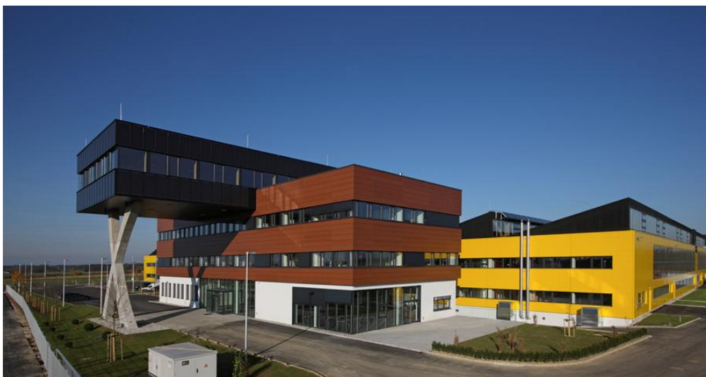
Abbildung 6: Außenansicht Passivhaus Industriebau Sunmaster/ Xolar (Quelle: Sunmaster)
