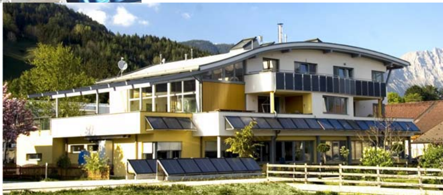
Abb. 5 – links: Außenansicht mit Blick auf Kühlturm und Kältemaschine, rechts: Schema der Einbindung der Solaranlage mit Speicherbeladung und der solaren Kälte in das Verteilernetz, unten: Außenansicht der Fa. Bachler [Quelle: Fa. Bachler]
