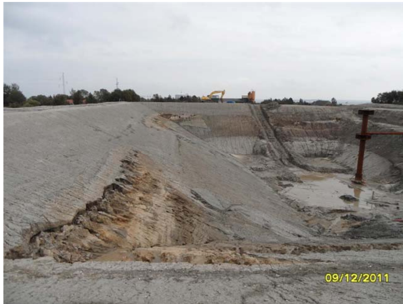
Abb. 3: Baustelle des Erdreich-Wärmespeichers in Marstal im September 2011
