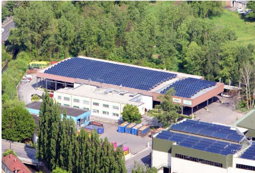
Abb. 2: Teil der Solaranlage AEVG
