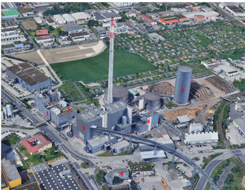
Abb. 1: Übersicht Fernheizwerk Linz Mitte
