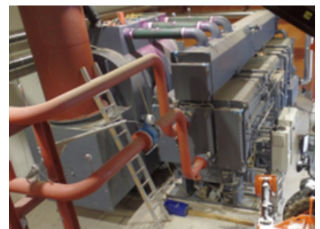
Abb. 20: Einbau der Absorptionswärmepumpe, Bildquelle: StepsAhead
