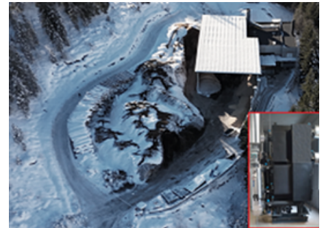
Abb. 15: Einbau der Absorptionswärmepumpe, Bildquelle: StepsAhead
