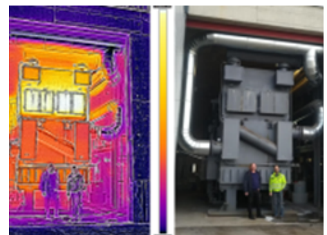
Abb. 17: Einbau der Absorptionswärmepumpe, Bildquelle: StepsAhead
