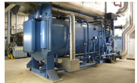
Abb. 22: Einbau der Absorptionswärmepumpe, Bildquelle: StepsAhead
