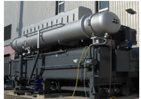
Abb. 19: Einbau der Absorptionswärmepumpe, Bildquelle: StepsAhead
