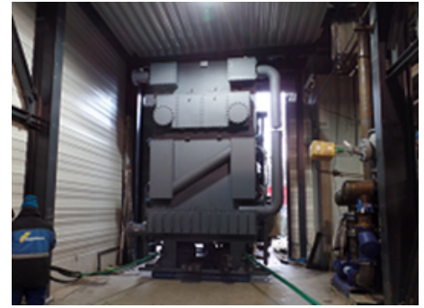
Abb. 18: Einbau der Absorptionswärmepumpe, Bildquelle: StepsAhead
