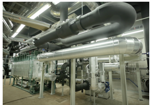
Abb. 23: Einbau der Absorptionskälteanlage Wien Hauptbahnhof, Bildquelle: Wien Energie
