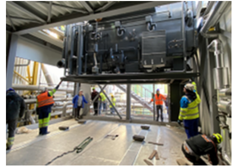
Abb. 21: Einbau der Absorptionswärmepumpe, Bildquelle: StepsAhead
