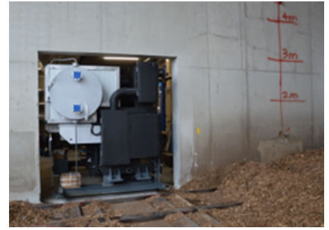
Abb. 14: Einbau der Absorptionswärmepumpe, Bildquelle: StepsAhead
