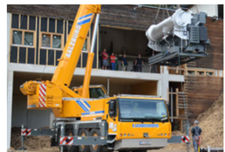
Abb. 13: Einhebung der Absorptionswärmepumpe, Bildquelle: StepsAhead
