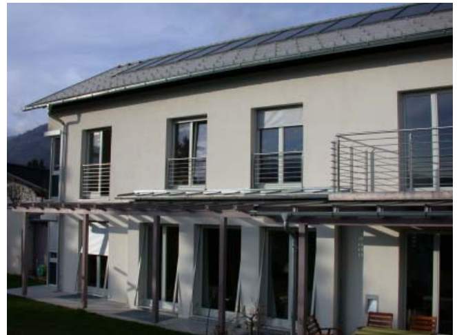
Abb 1: Übliche Kollektorflächen für solare Kombianlagen bewegen sich zwischen 15 und 40 m 2 (Bildquelle: AEE INTEC)
