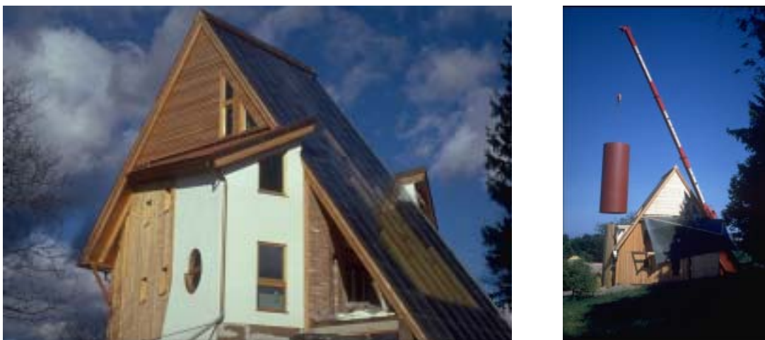
Abbildung 23: Ansicht eines vollsolar versorgten Einfamilienhauses mit 85 m 2 Bruttokollektorfläche auf der Laßnitzhöhe, Steiermark (links). Versetzen des 75 m 3 fassenden Energiespeichers per Kran (rechts)
