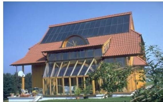
Abbildung 6: Solararchitektur kombiniert mit einer thermischen Solaranlage zur Brauchwasserbereitung und Raumheizungsunterstützung. (Bildquelle: AEE INTEC)
