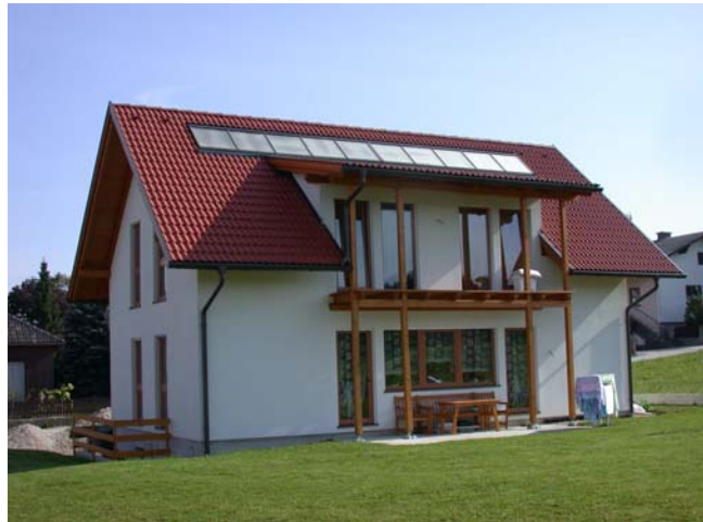
Abbildung 3: Einfamilienhaus mit einer Solaranlage zur Brauchwasserbereitung und Raumheizungsunterstützung (Bildquelle: AEE INTEC)
