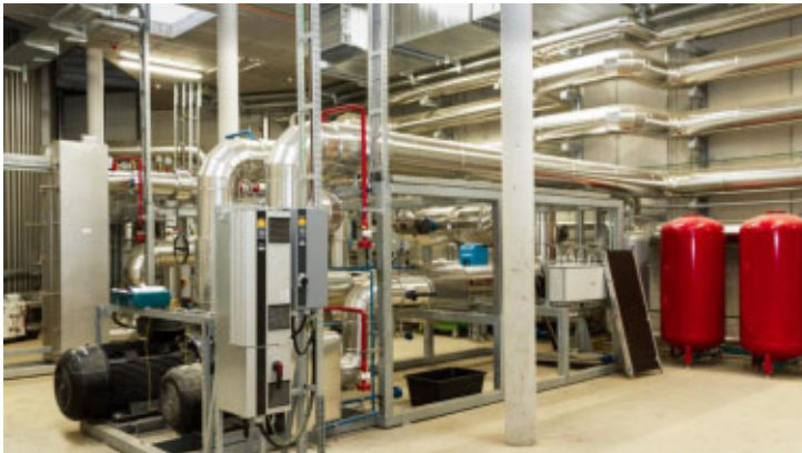
Charge-/Discharge unit tank ↔ DH grid
