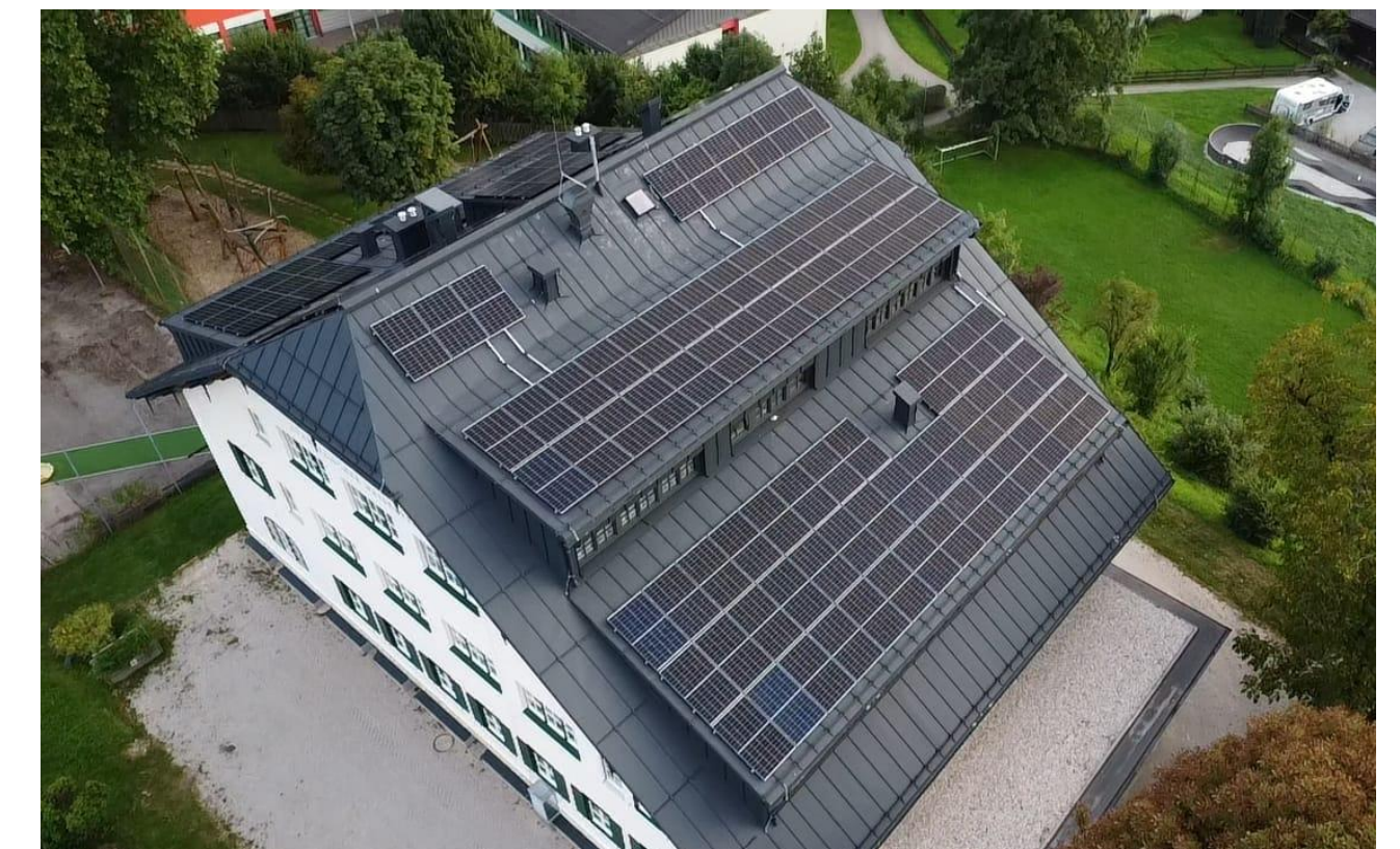
Umsetzung PV Anlage Bad Goisern Fotos: SOLPRO / Diakonie Eine Welt
