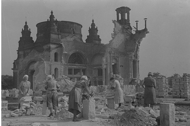
Abbildung 11. Händische Bergung intakter Mauerwerkssteine aus Trümmerschutt und Entfernung von Mörtelresten (das sog. „Ziegelputzen“), ca. 1946; Quelle: Deutsche Fotothek, CC BY-SA 3.0 DE < https://creativecommons.org/licenses/by-sa/3.0/de/deed.en >, via Wikimedia Commons
