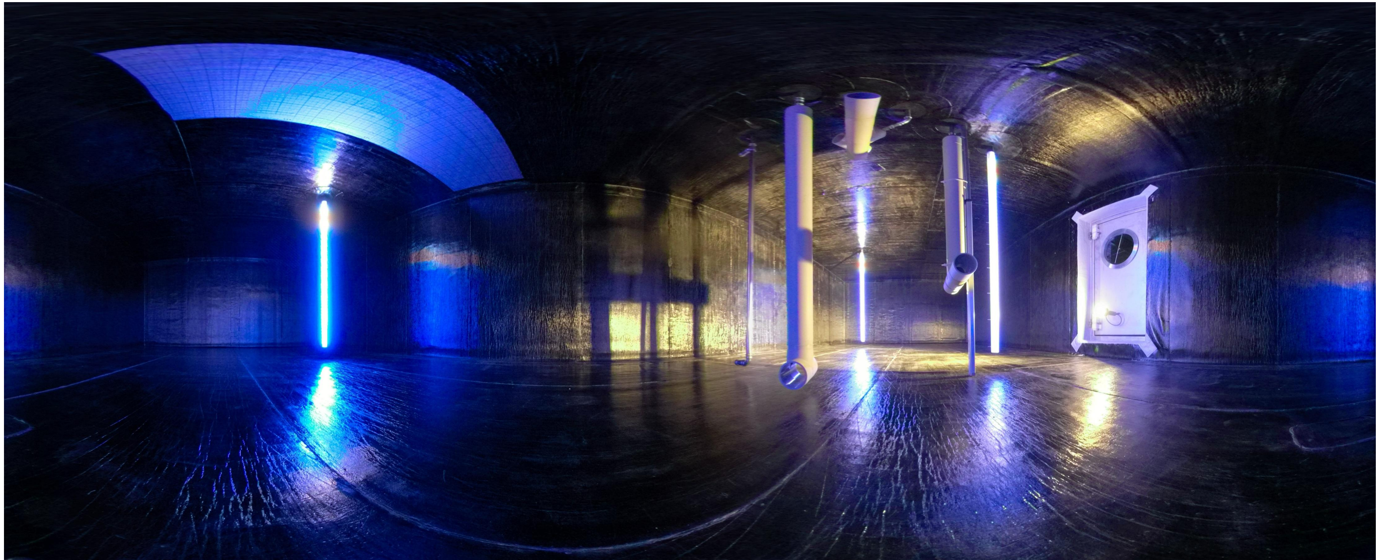
Abb.: Pilotspeicher (Quelle: HSLU)
